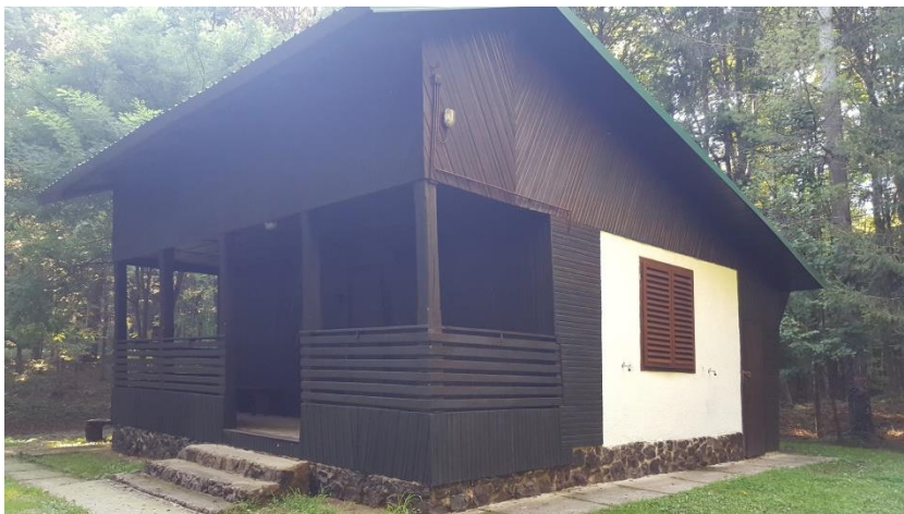
Slika 96. Zatvoreni objekt Ćirina kućica
