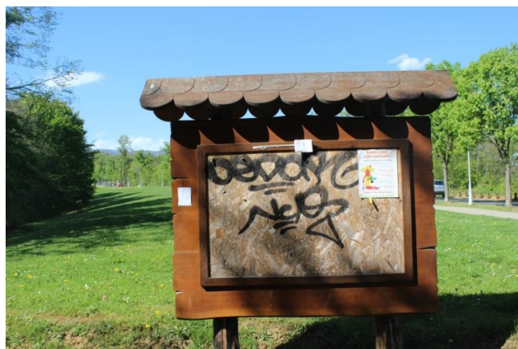
Slika 16. Prikaz vandalizma na poučnoj tabli postavljenoj na Dubravkinom putu u Zagrebu (foto: Tikvić, 2016.)
