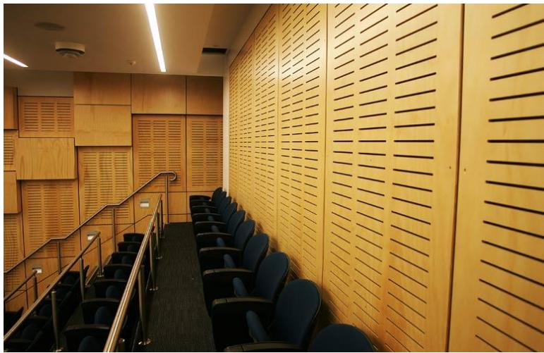
Slika 21 Primjer postavljenih perforiranih ploča u dvorani (Alibaba.com)
