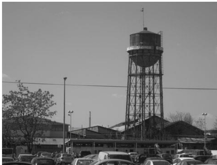
Slika 9. Vodotoranj Gredelj (DAZ, 2012.)
