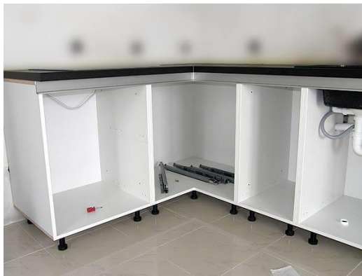
Slika 16 Korpusi kuhinjskih elemenata izrađeni od iverice
