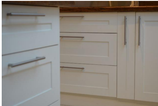
Slika 19 Fronte izrađena od MDF ploča Izvor: http://customwritingink.com/mdf-kitchen-cabinet-doors.html
