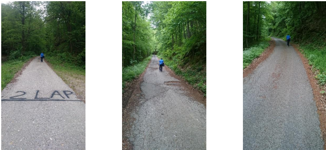
Slika 6. Izgled dionice D-2 pješačke staze
