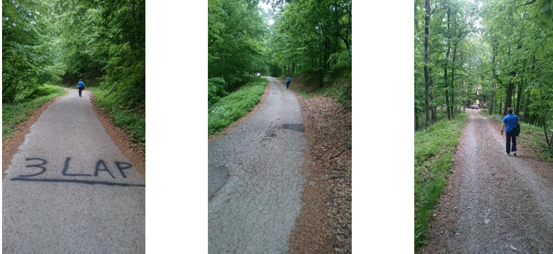
Slika 7. Izgled dionice D-3 pješačke staze
