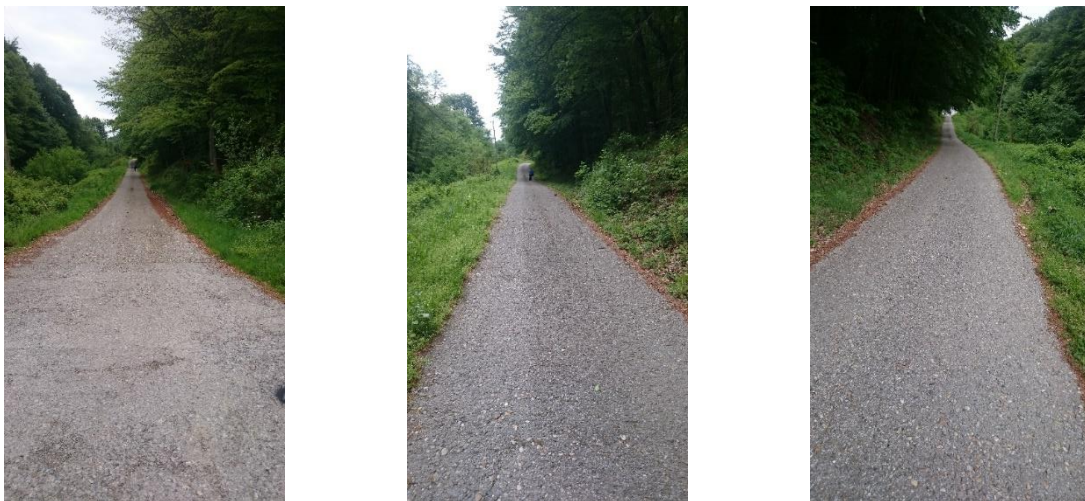
Slika 4. Izgled dionice D-0 pješačke staze
