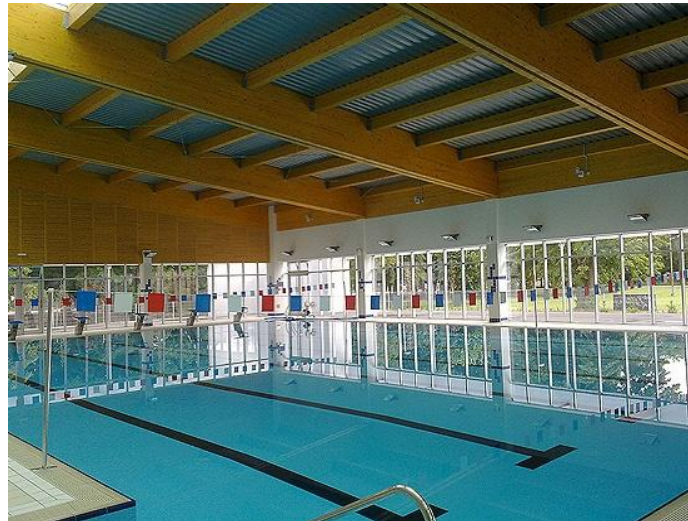
Slika 10. Bazeni u Vinkovcima. Kontinuirana greda raspona 22,50+12,00 m http://drvene-konstrukcije.hr/karakteristike-llld/
