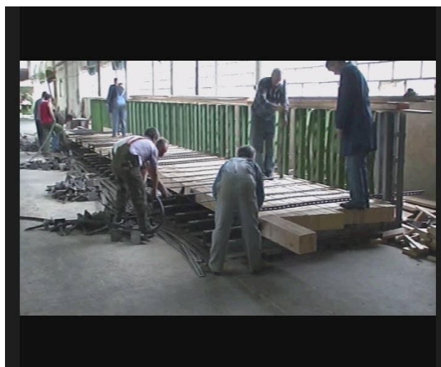
Slika 15. Postolje za pritezanje lamela http://drvene-konstrukcije.hr/karakteristike-ld/
