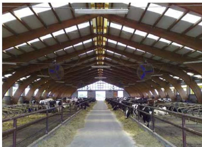
Slika 9. Farma muzenih krava - trozglobni okvir raspona 26,80 m. http://drvene-konstrukcije.hr/karakteristike-lld/
