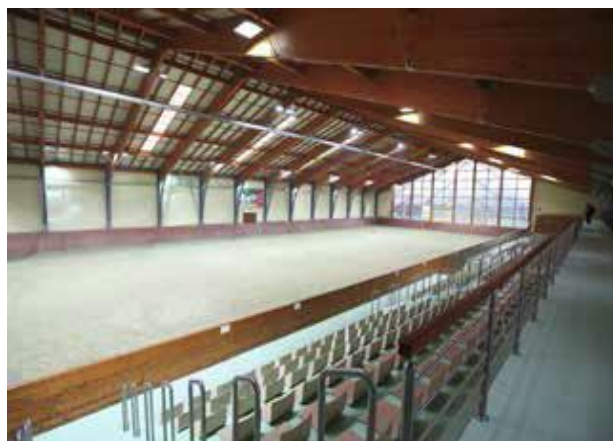
Slika 3. Ergela lipicanaca Đakovo. Trozglobni okvir, raspon 37,60 m. Stupovi - čelik, grede - LLD. http://drvene-konstrukcije.hr/karakteristike-llld/
