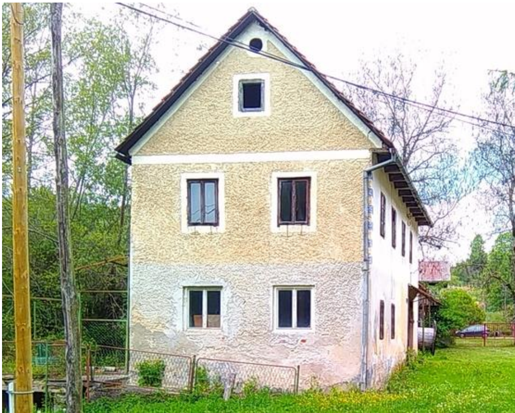
Slika 27. Bočni pogled na glavnu zgradu u postojećem stanju (Fotografija: Klanfar, F.)
