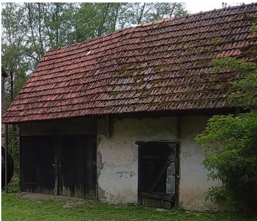
Slika 73. Kovačnica u postojećem stanju (Fotografija: Klanfar, F.)
