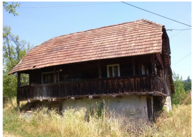
Slika 75. Drvena žumberačka kuća 2 (Fotografija: Klanfar, F.)
