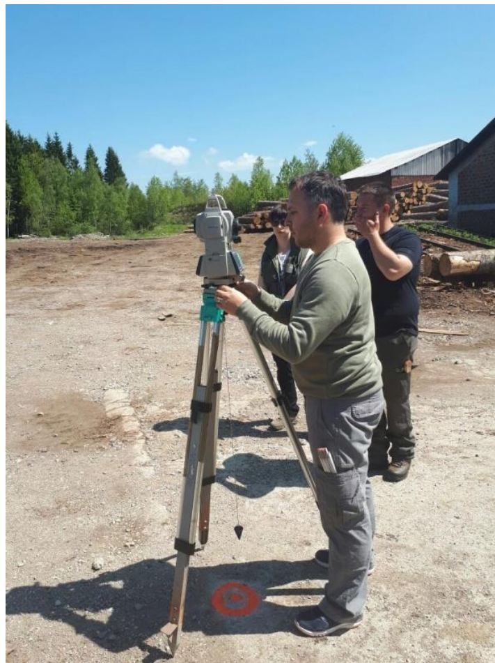
Slika 11. Rad geodetskom radnom stanicom
