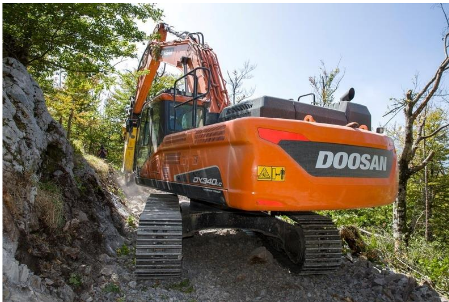
Slika 12. Izgradnja šumske ceste na nagnutom terenu, bager sa hidrauličnim čekićem
