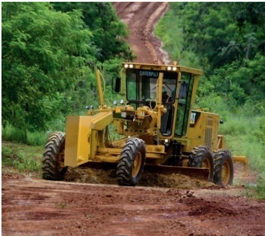
Slika 13. Održavanje ceste primjenom grejdera
