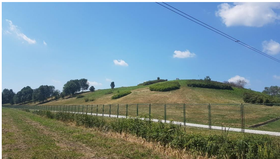
Slika 8. Pogled na sanirani dio odlagališta (Vojković, 2017.)
