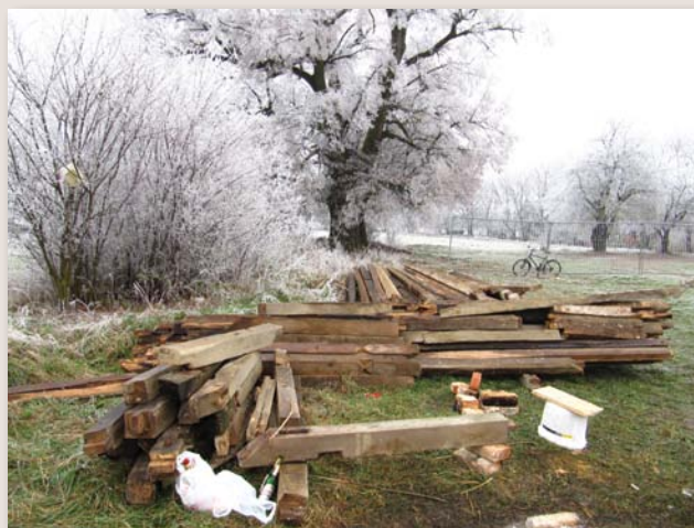
Slika 2. Građevinski radovi na kuriji u blizini stare lipe bez jasno definirane zaštitne zone oko stabla (ZZOS)
