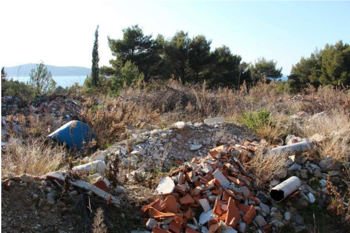
Slika 4. Nelegalno odlaganje građevinskog otpada
