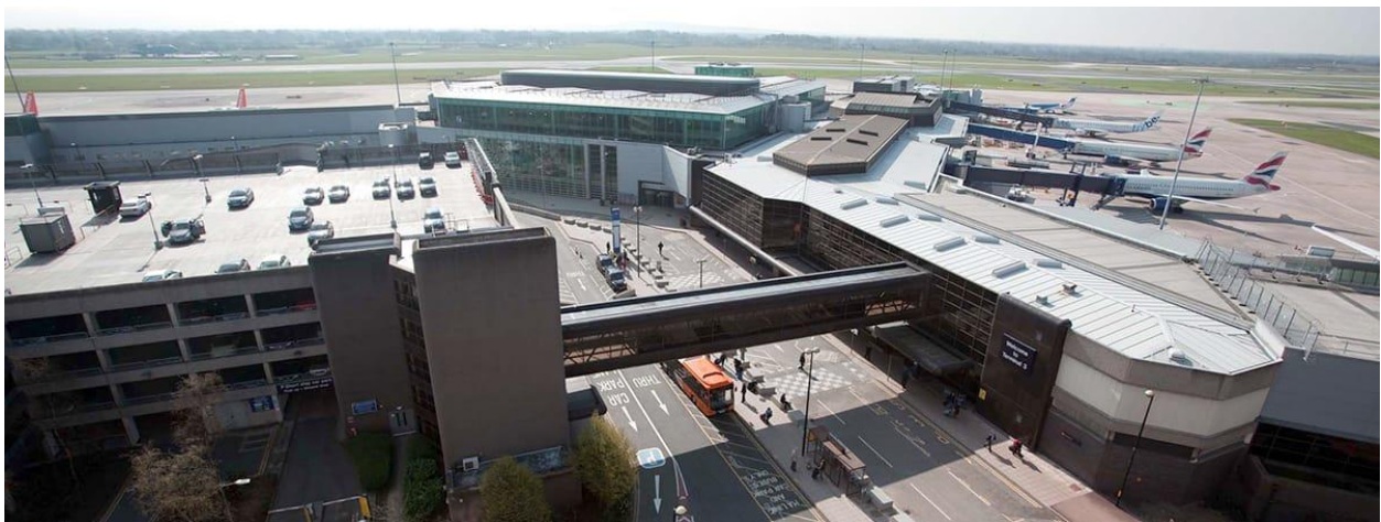
Slika 11: Topli prolaz kod zračne luke „Manchester Airport“ ( www.manchesterairport.co.uk , 2018. )
