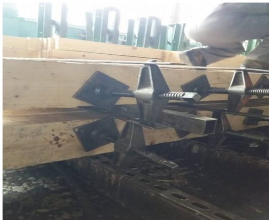
Slika 23. Pritezanje stezačima
