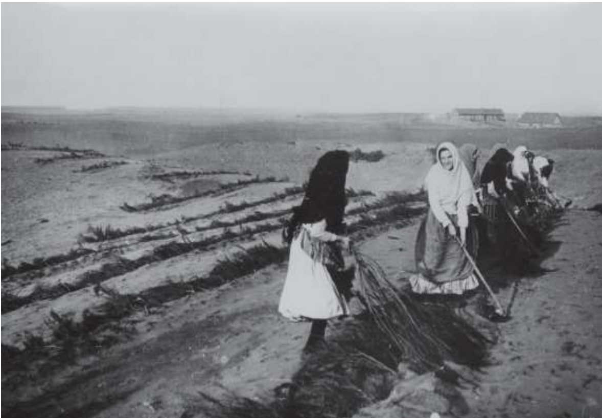
Slika 6. Radovi na smirivanju pijesaka (Foto: F. Šandor , oko 1910.; izvor: Vrbeč i Pilaš, 2011)
