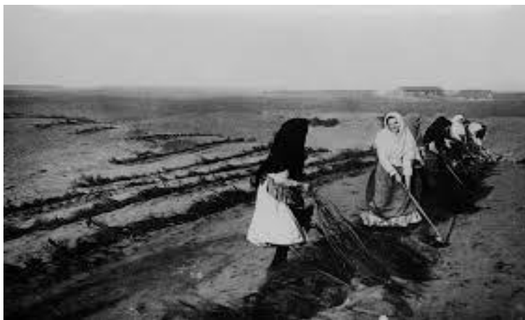
Slika 1. Radovi na smirivanju pijeska u Đurđevcu (foto: F. Šandor, 1910)
