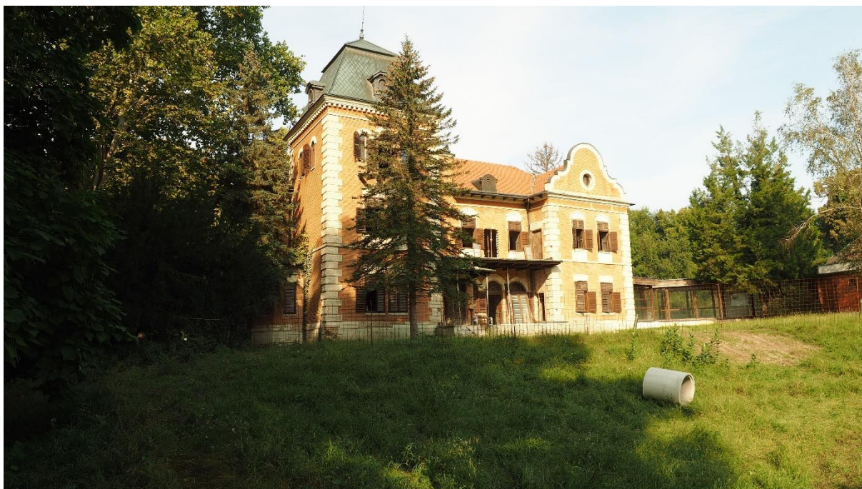
Slika 1. Glavni dvorac kompleksa Tikveš. Ispred je vidljiva posađena bodljikava smreka
