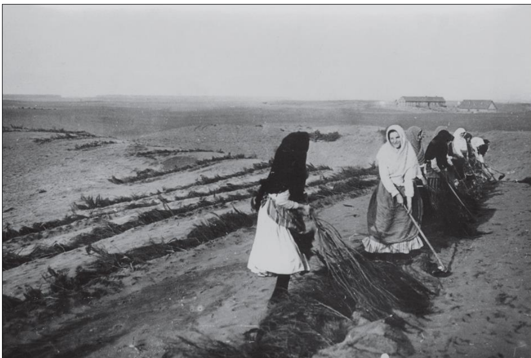
Slika 2. Gradnja zaštitnog pojasa polaganjem grana u jarke (foto: F.Šandor)
