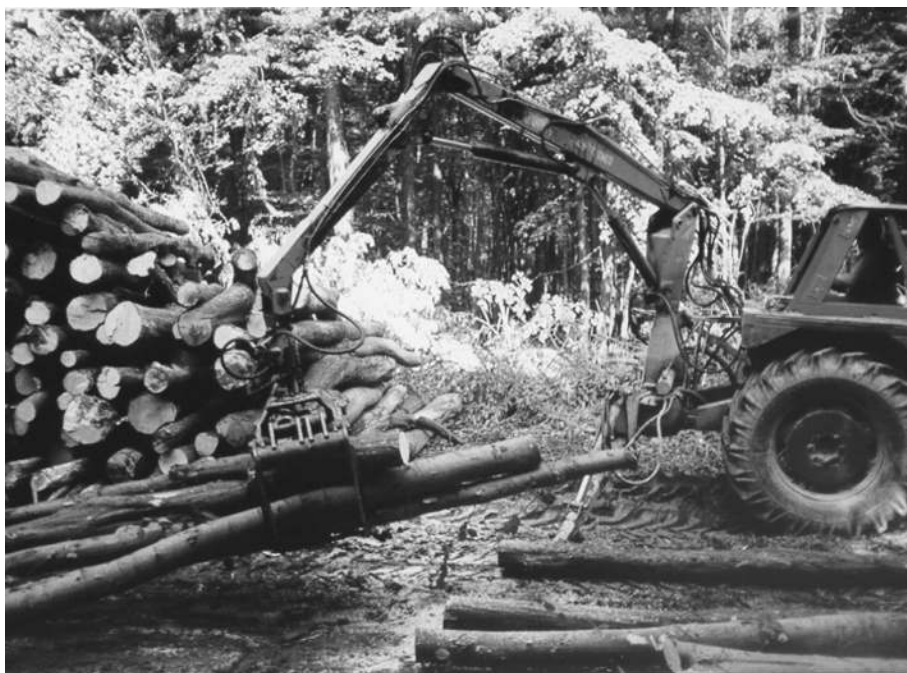
Slika 1. Traktor s dizalicom pri slaganju višemetarskoga drva na pomoćnom stovarištu Fig. 1 Tractor with crane during stacking of long timber on the landing
