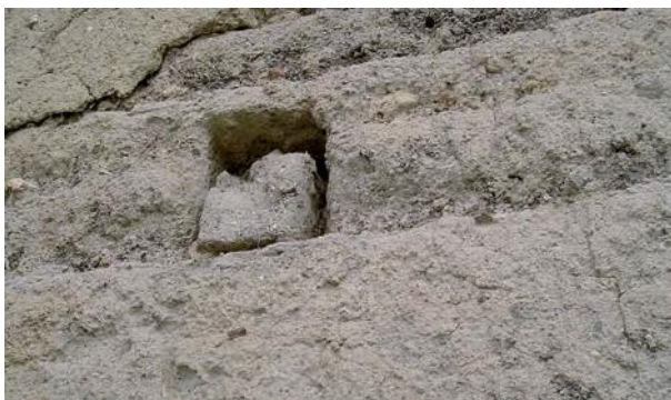
Slika 8 Zidovi od naboja Izvor: Lončar-Vicković i Stober, 2011
