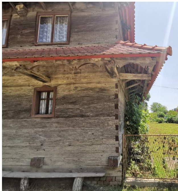
Slika 2. Detalj pročelja kuće u Krapju Fotografija: Lozančić i sur., 2020.
