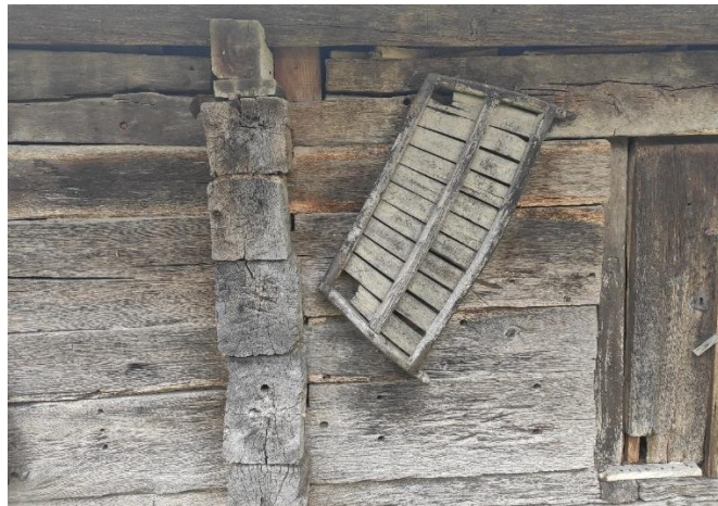
Slika 39. Detalj pročelja, Donja Kupčina
