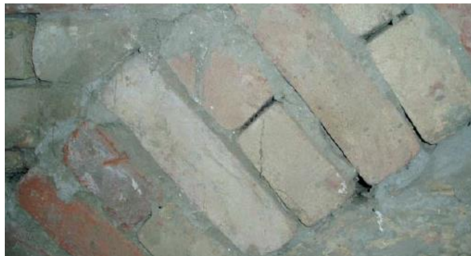
Slika 10 Zidovi od opeke Izvor: Lončar-Vicković i Stober, 2011
