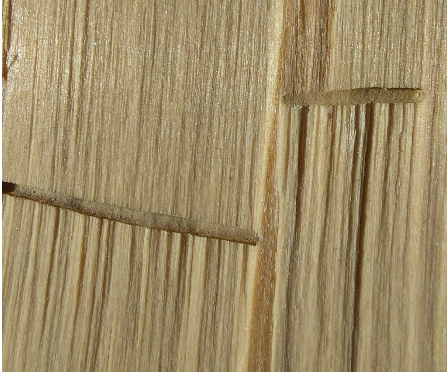
Slika 20: Uzdužni presjek hodnika bez vidljivih gljivica
