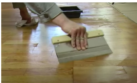
Slika 7. Nanošenje ulja lopaticom
