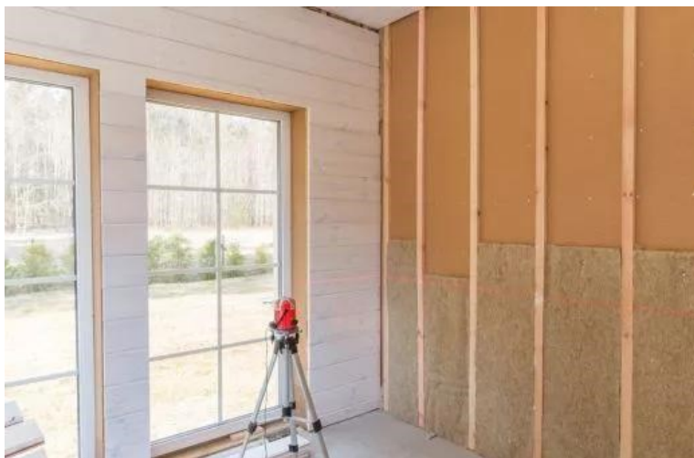
Slika 17. Izolacijske ploče od drvenih vlakana (web 9)
