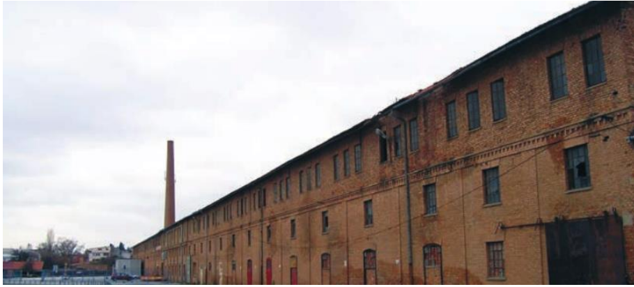
Slika 75: Zgrada ciglane (Izvor: http://www.casopis-gradjevinar.hr/assets/Uploads/JCE-67-2015-11-8-Ind-bastina.pdf Pristupljeno: 15.7.2021.)
