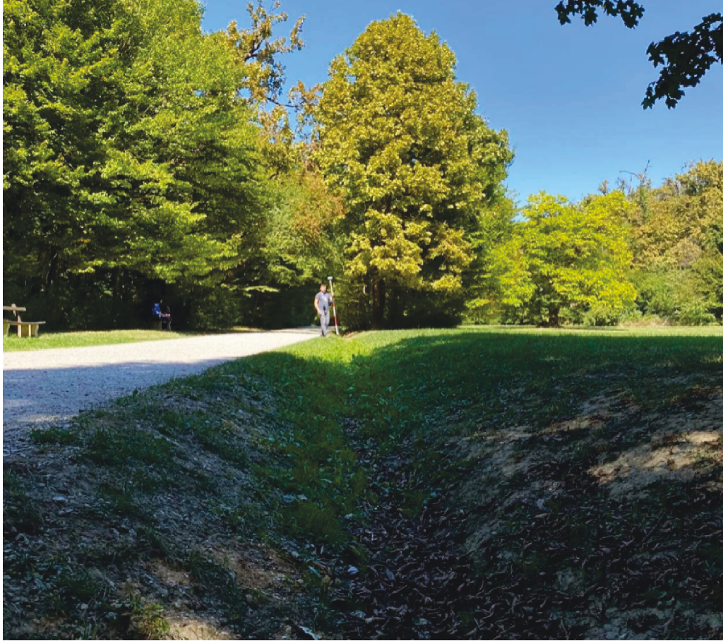
Slika 35. Odvodni jarak uz livadu orema 4. jezeru
