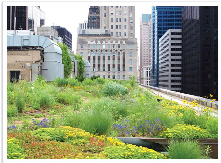
Slika 3. Ekstenzivni zeleni krov [9]
