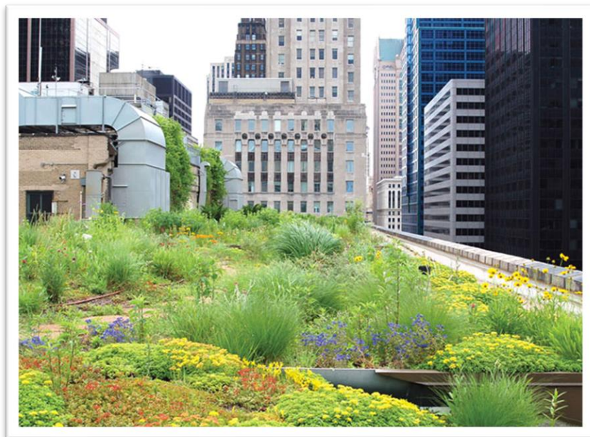
Slika 3. Ekstenzivni zeleni krov [9]
