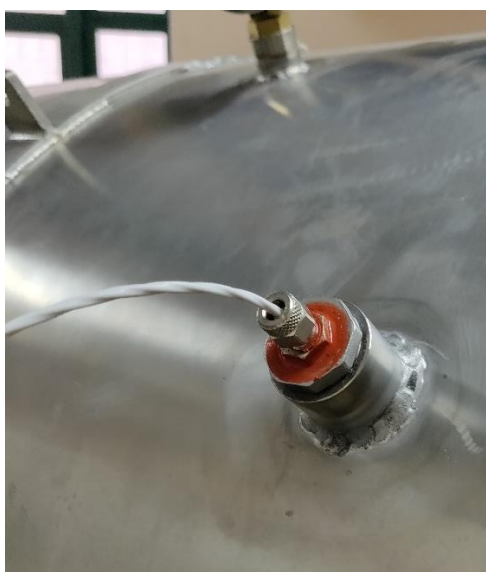
Slika 16: Ugrađen i zabrtvljen termopar (fotografija: Kvakon, 2022.)
