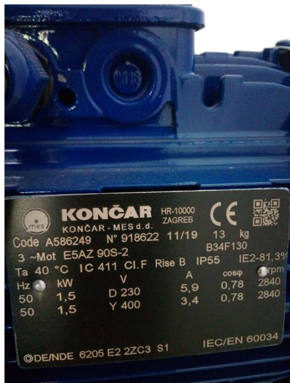
Slika 14. Natpisna pločica elektromotora
