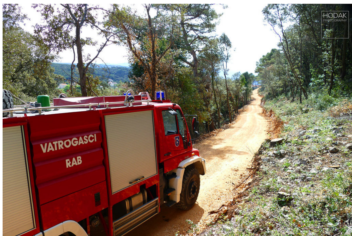
Slika 10. Novoizgrađena protupožarna prosjeka s elementima ceste na dionici Pidoka-Mel (Izvor: https://www.rabdanas.com/index.php/vijesti/item/4736-dovrsenjem-izgradnje-prosjeke-pidoka-mel-osigurana-vazna-linija-protupozarne-obrane-sumovitog-poluotoka-kalifront )
