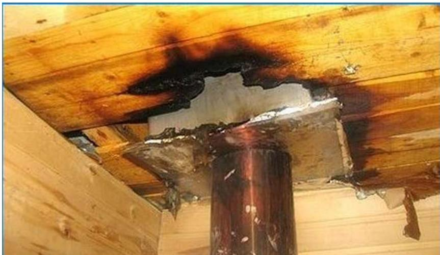
Slika 5. Prikaz pougljenog sloja drva nastao pri požaru
