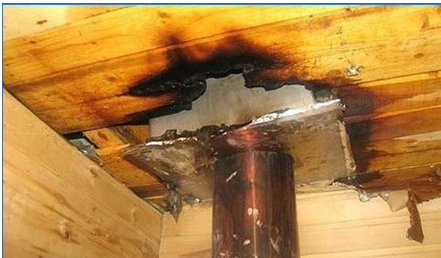
Slika 5. Prikaz pougljenog sloja drva nastao pri požaru
