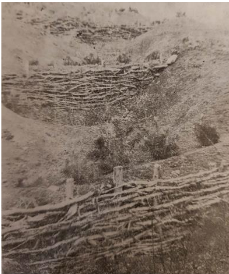
Slika 24. Pleterima tretirana vododerina malog sliva je škarpirana, a zatim su na zaplavim su na zaplavima sađene listače i borovi (Izvor: Lujčić 1973)
