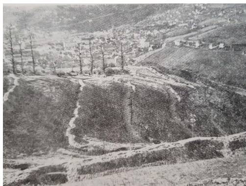
Slika 6. Infiltracijske bankete alžirskog tipa (Izvor: Lujčić 1973)
