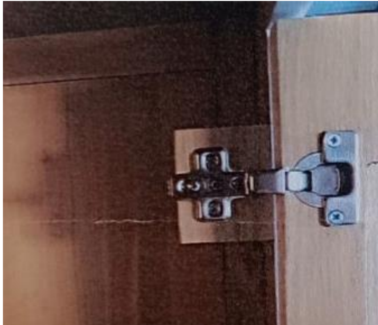
Slika 10. Odmična zglobnica
