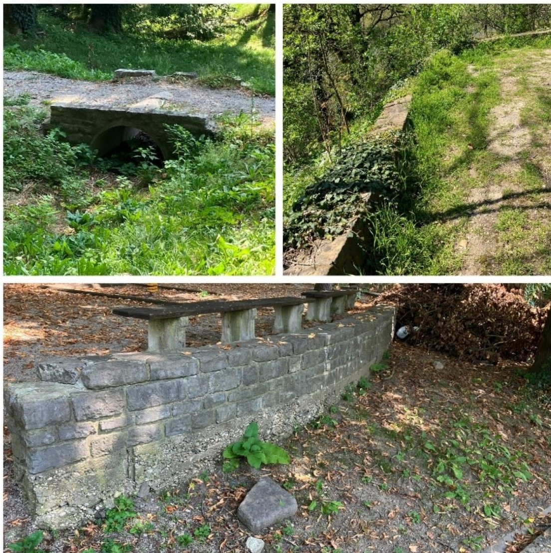
Slika 9. Izgled kamenog zida
