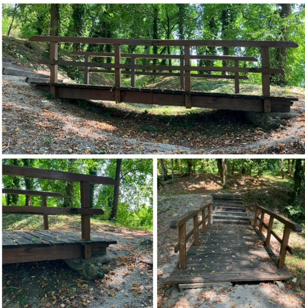
Slika 11. Izgled drvenog mosta
