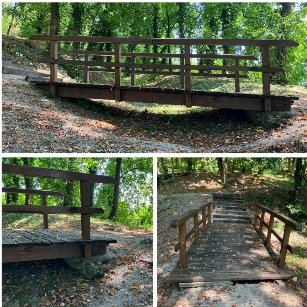
Slika 11. Izgled drvenog mosta
