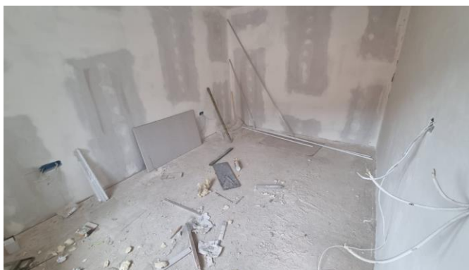
Slika 9. Nedovršeni prostor 3 na lokaciji 1
