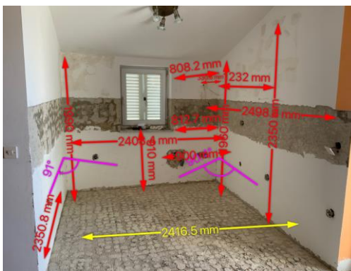
Slika 16 Nedovršeni prostor 3 na lokaciji 3
