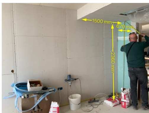
Slika 13. Nedovršeni prostor 4 na lokaciji 2
