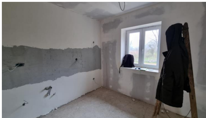
Slika 7. Nedovršeni prostor 1 na lokaciji 1
