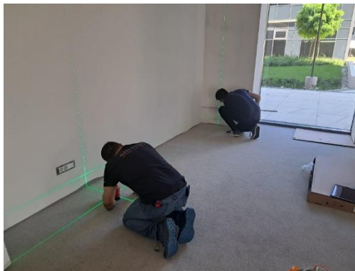
Slika 17. Izmjera prostora 1 na lokaciji 4
