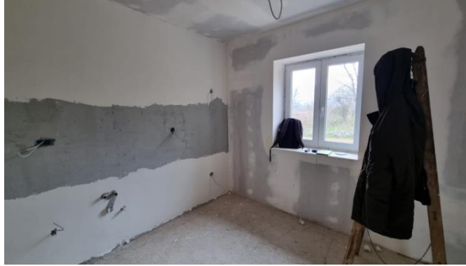
Slika 7. Nedovršeni prostor 1 na lokaciji 1
