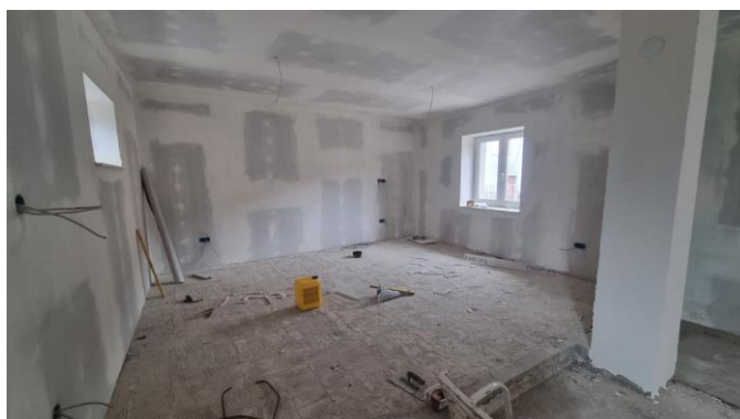
Slika 8. Nedovršeni prostor 2 na lokaciji 1
