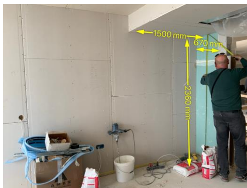
Slika 13. Nedovršeni prostor 4 na lokaciji 2
