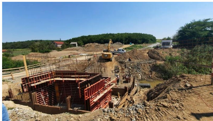
Slika 14. Radovi na izgradnji mosta na kanalu Jošava, srpanj 2023. (Izvor: Fabijan Šarčević)
