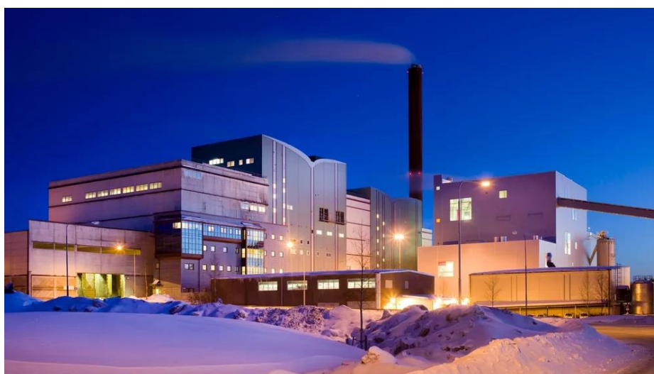
Slika 9. Postrojenje Dåva 1. (Izvor: https://www.umeaenergi.se/varme/miljo/dava-1-och-2 )
