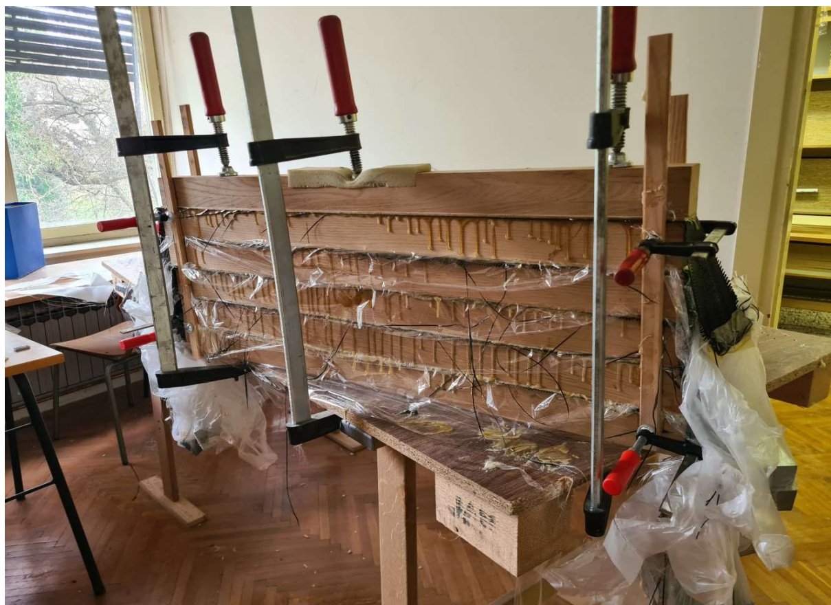
Slika 10. Završno lijepljenje ojačanja i elemenata
