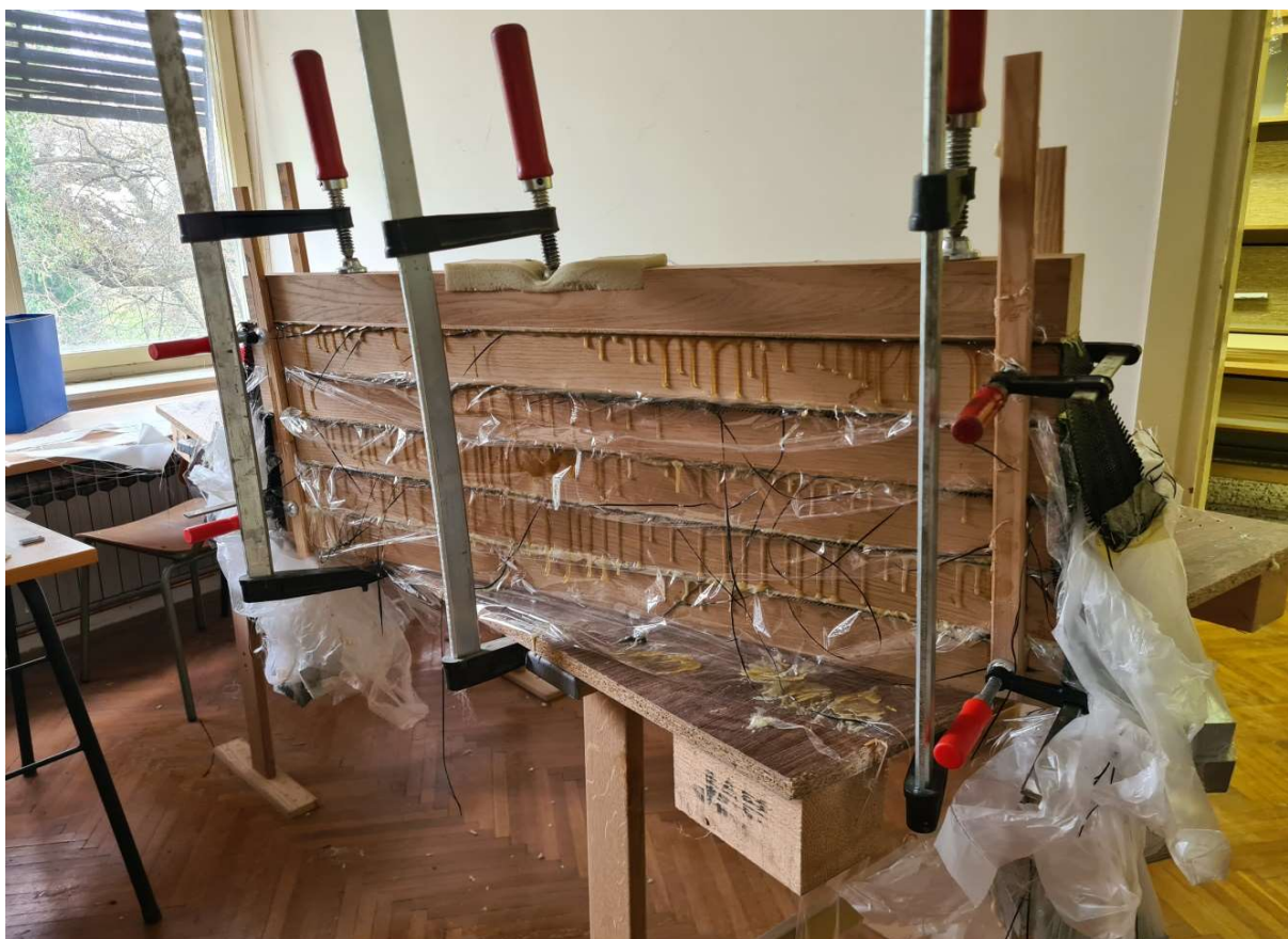
Slika 10. Završno lijepljenje ojačanja i elemenata
