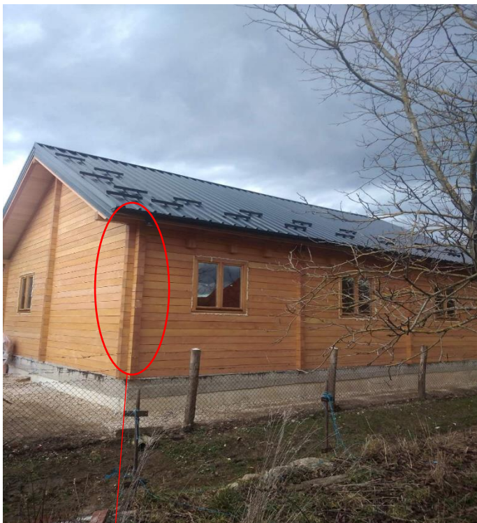
Slika 5. Prikaz lamelirane grede na postojećoj drvenoj kući, izvor: azelija.com
