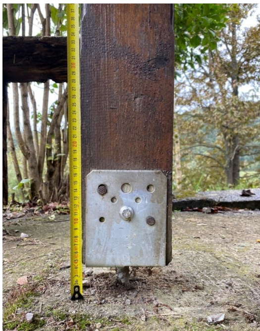
Slika 13. Snimka – detalj spoja stupa i temeljne ploče
