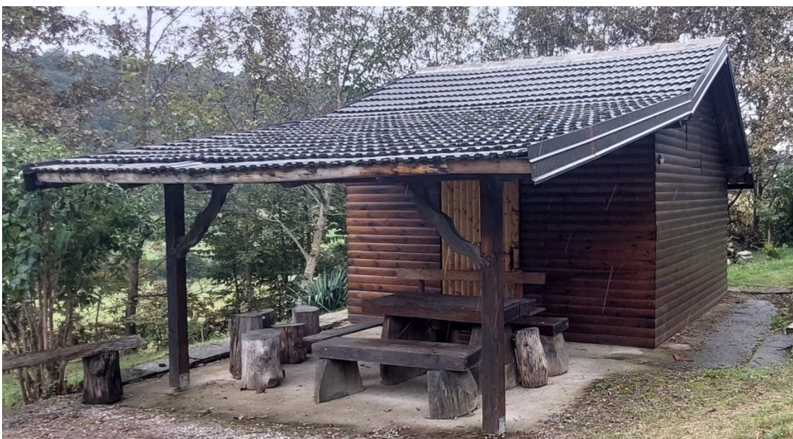
Slika 9. Snimka – SI pročelje s natkrivenim trijemom. Stupovi trijema na metalnim vilicama odvojeni od tla.
