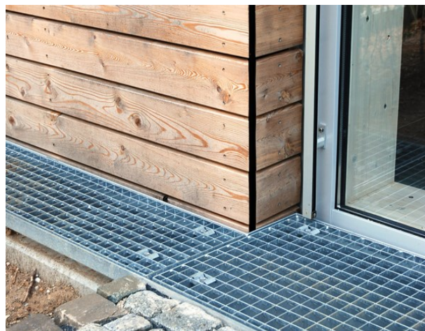
Slika 30. Primjer drenažnog kanala (zimmermeister-modernisieren.de)
