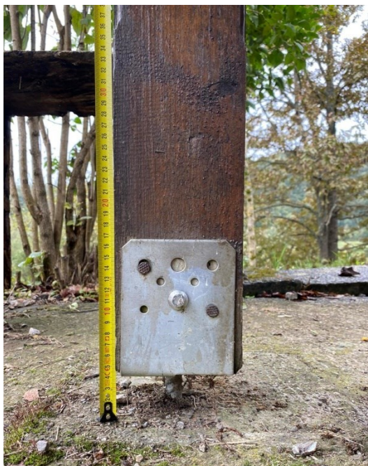
Slika 13. Snimka – detalj spoja stupa i temeljne ploče
