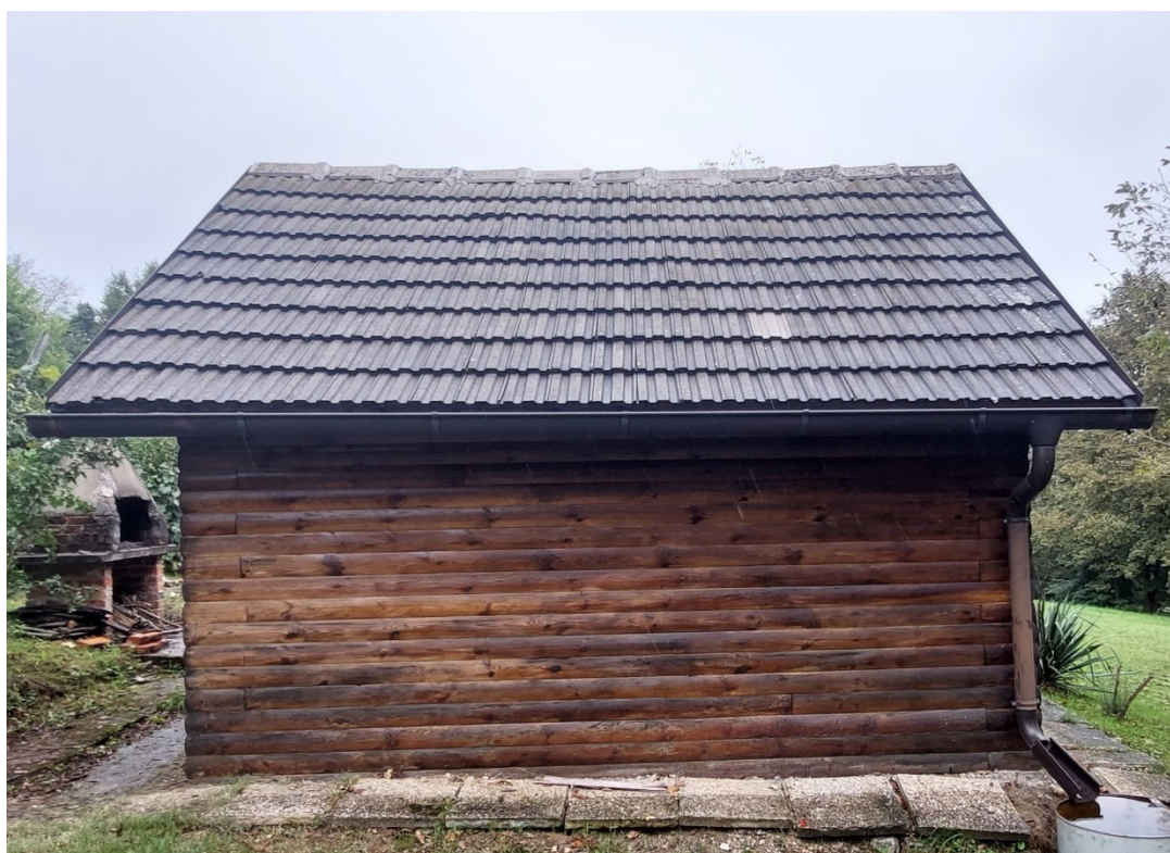
Slika 11. Snimka – Z pročelje. Elementi pročelja su spuštjeni do zemlje (betonskih opločnika).
