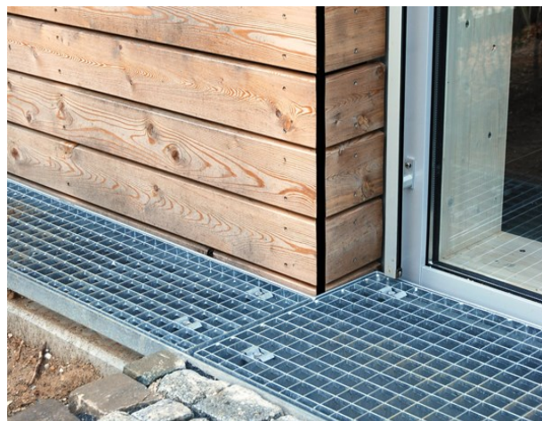
Slika 30. Primjer drenažnog kanala (zimmermeister-modernisieren.de)
