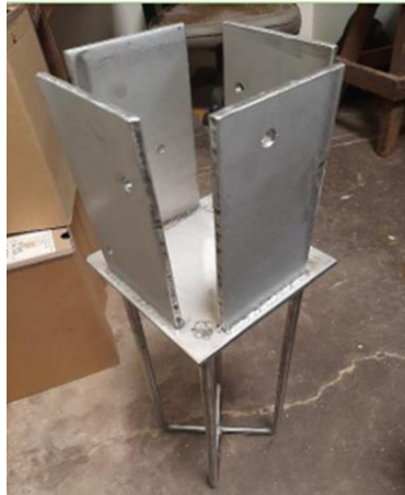
Slika 7. Primjer metalne stope koja se upotrebljava za postavljanje drvenih stupova pergole Izvor: White Glove Complete Assembly Service (foreverredwood.com)(Pristupljeno 19.9.2024.)
