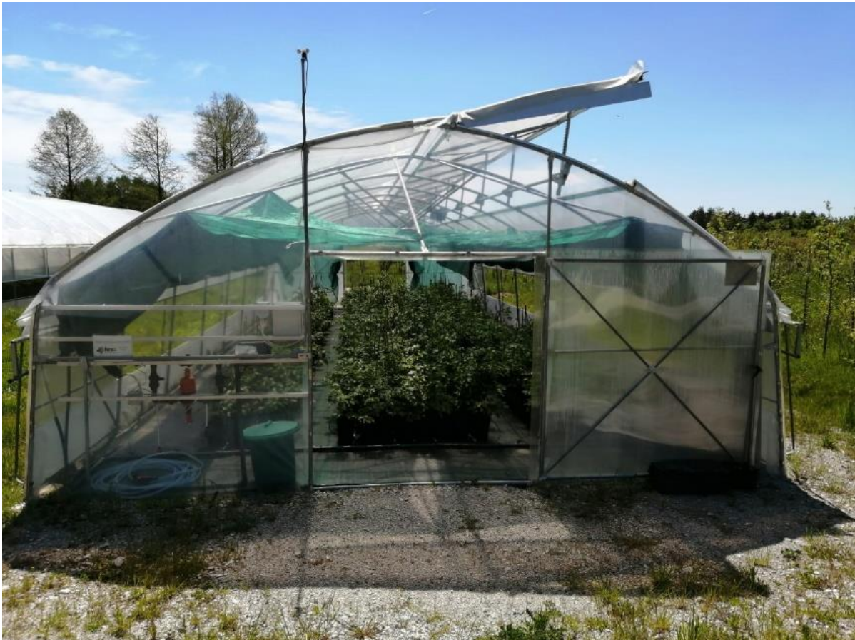
Slika 1. Plastenik opremljen pomičnim krovom korišten u ovom istraživanju
