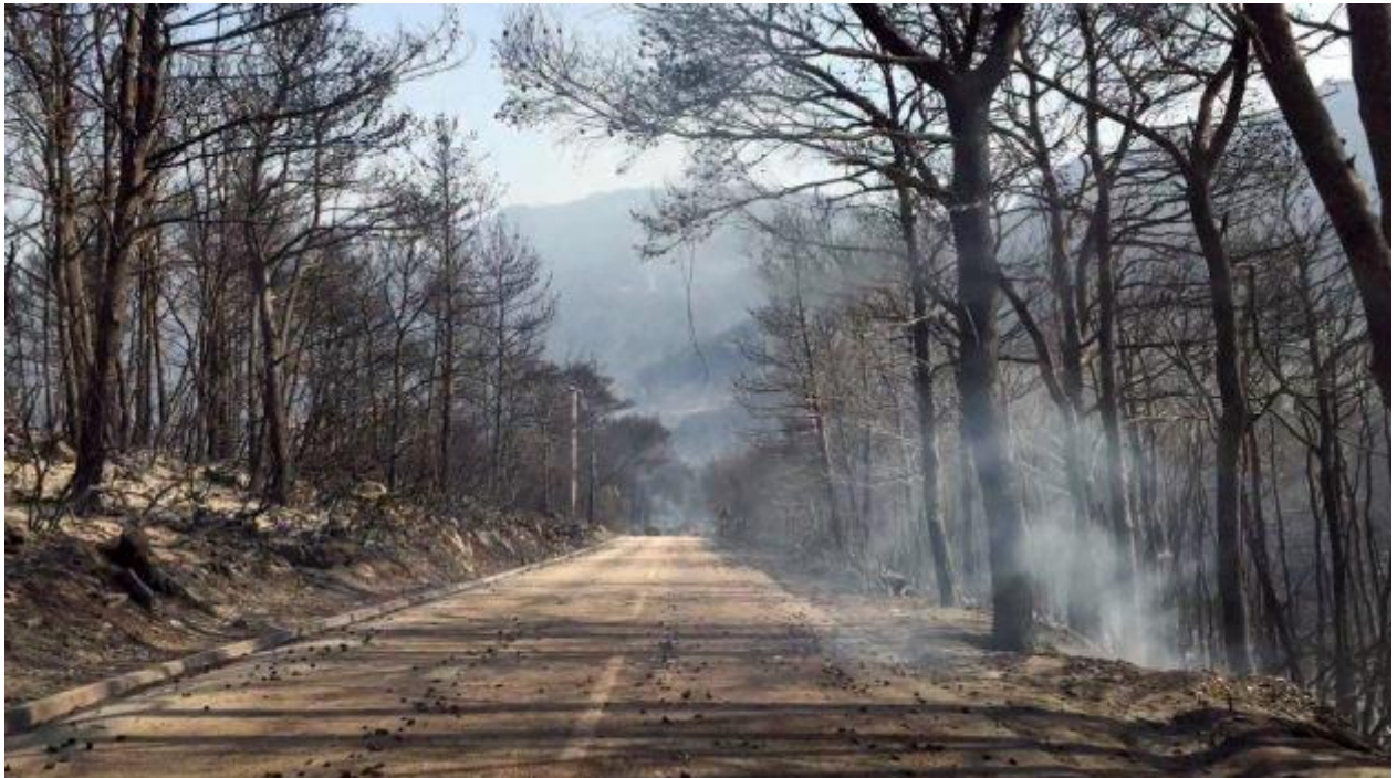
Slika 2. Prometnica koja je ispunila zadaću u paljenja protuvatre
