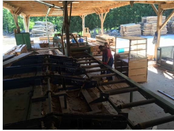
Slika 19. Odvozne rampe sa separatorima
