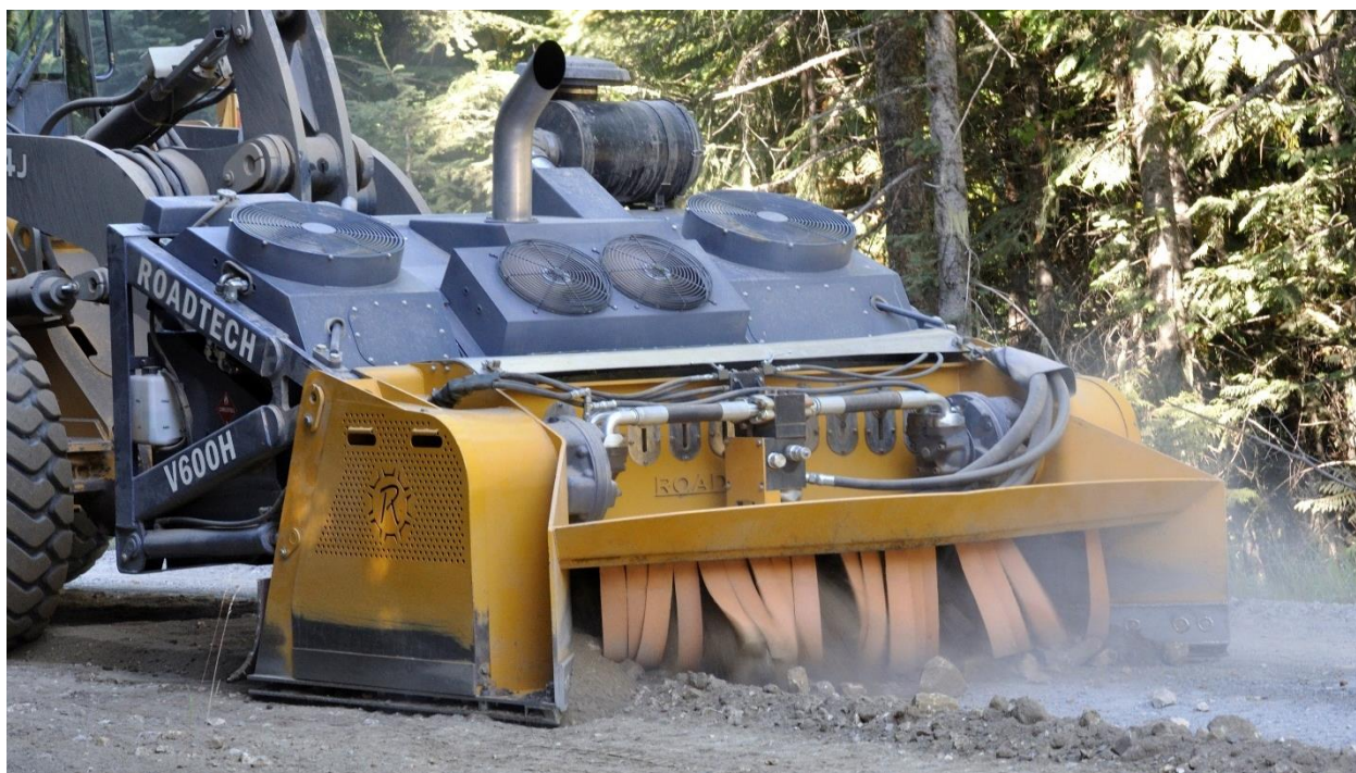
Slika 4. Metoda popravka kolnika drobljenjem kamenog materijala
